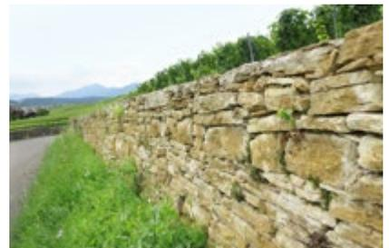
Um die Stabilität der Mauer nicht zu gefährden, darf der Sand erst eingebracht werden, nachdem die Mauersteine stabil aufgebaut und gut hintermauert sind.
